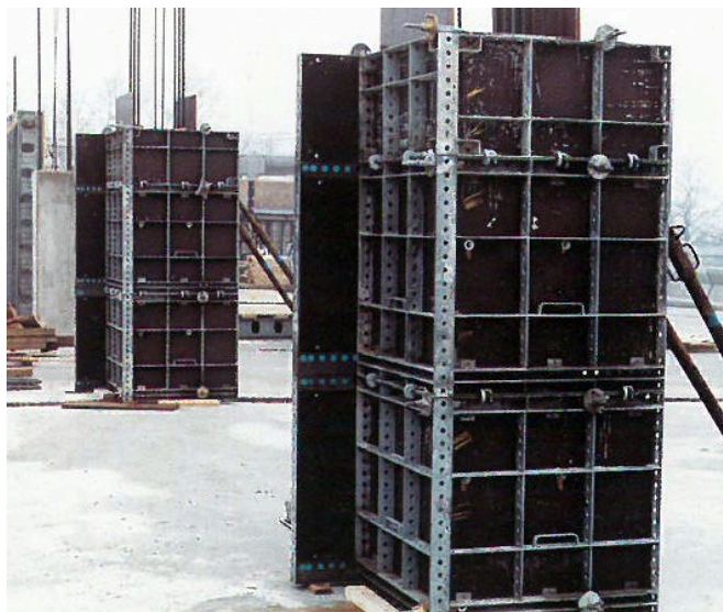
Przykład zastosowania płyt przy słupach.
