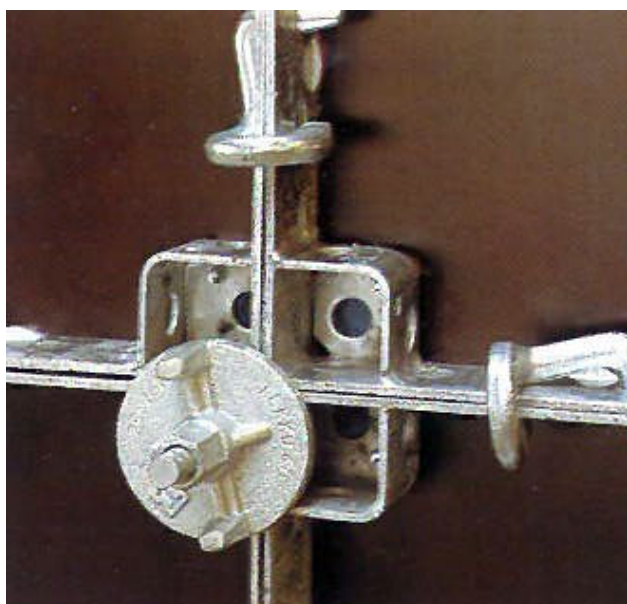
Połączenie płyt z zastosowaniem nakrętki.
