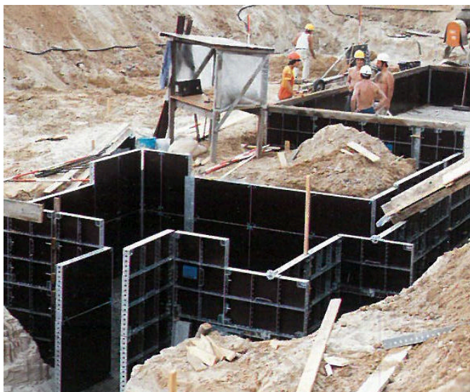
Ławy i ściany fundamentowe o złożonym przebiegu.
