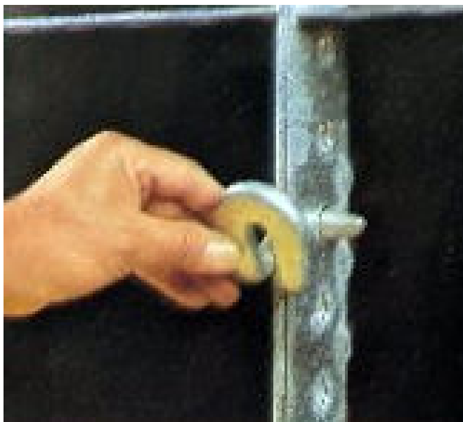
1. Wprowadzenie zamka w połączenie płyt.
