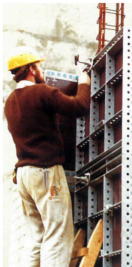
Montaż układu na budowie.
